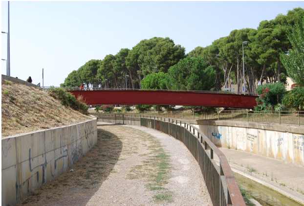
(a) Vista de la pasarela desde la senda peatonal habilitada en la margen derecha del encauzamiento del río Isuela
