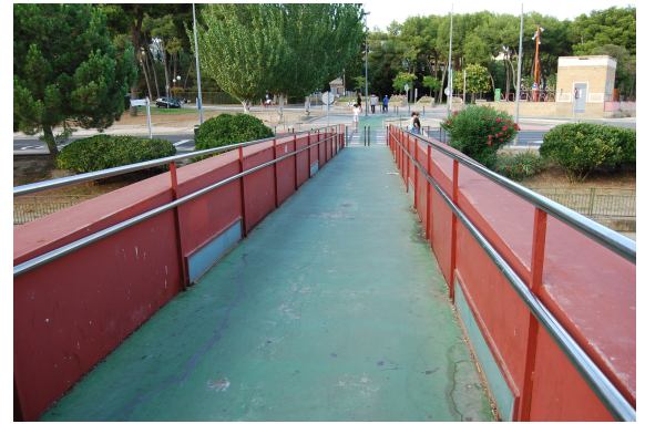
(b) Acceso a la pasarela desde margen derecha, en dirección al Parque del Encuentro
